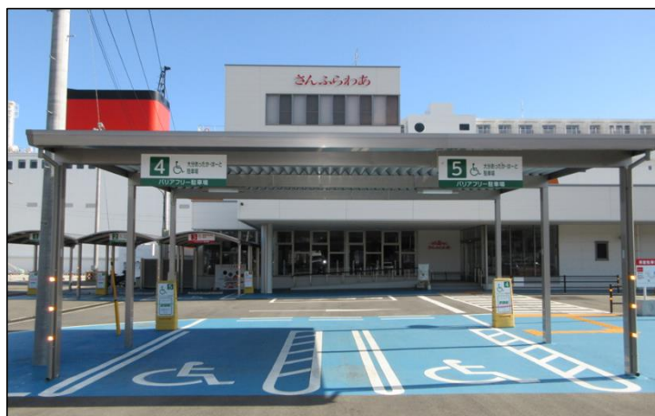
フェリーターミナル 屋根付きのスルー型駐車スペース
